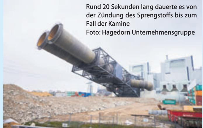
Rund 20 Sekunden lang dauerte es von der Zündung des Sprengstoffs bis zum Fall der Kamine
